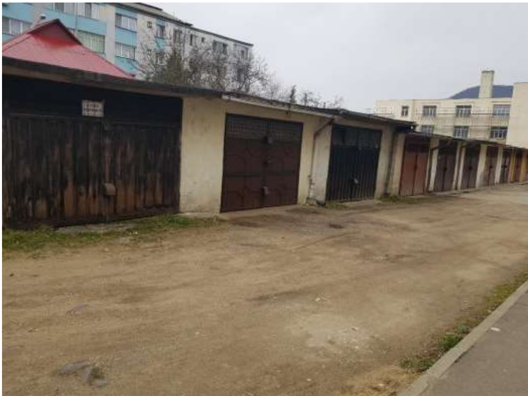
Figură 48 - Baterii de garaje Baia Mare – Cartierul Depozit
