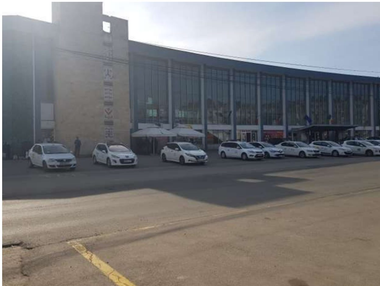
Figură 70 - Gara Baia Mare - Stație de Taxiuri
