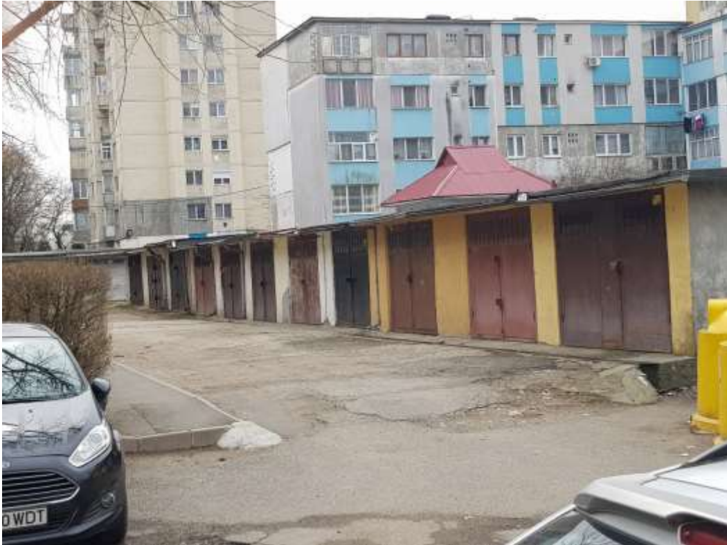
Figură 49 - Baterii de garaje Baia Mare – Cartierul Depozit
