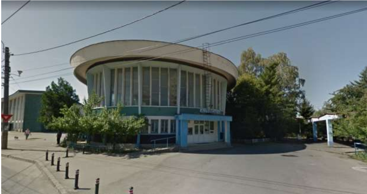
Figură 59 - Corp principal Autogara Baia Mare
